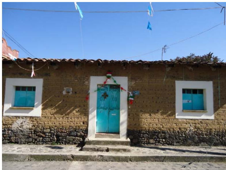
Casa de adobe en Tlayacapan, una de las pocas que aún persisten.
